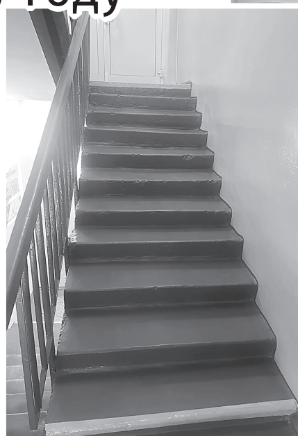
Косметический ремонт лестничных пролетов. Школа №50
