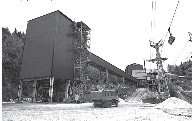
Фабрика первичного дробления, 2013 год. Позже канатная дорога была демонтирована
