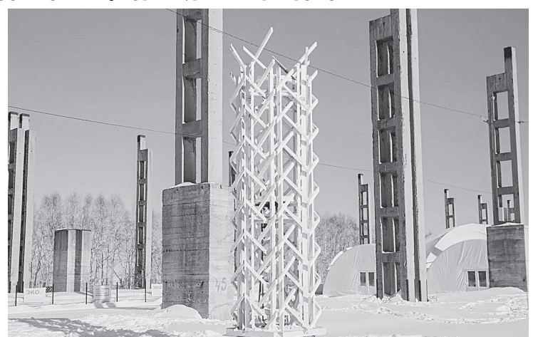
«Башня Южный Октагон»
